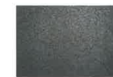
Surface en Béton Drainant (Place PMR et Circulations)
