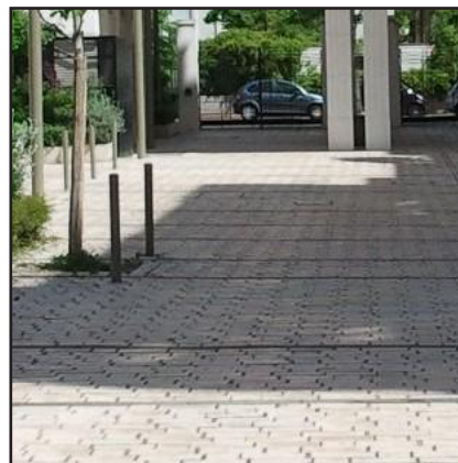
Pavage pierre naturelle joint concassé
