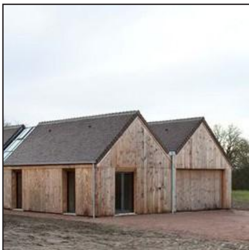
Maison individuelle, Barrault & Pressacco, Gonneville-sur-mer
