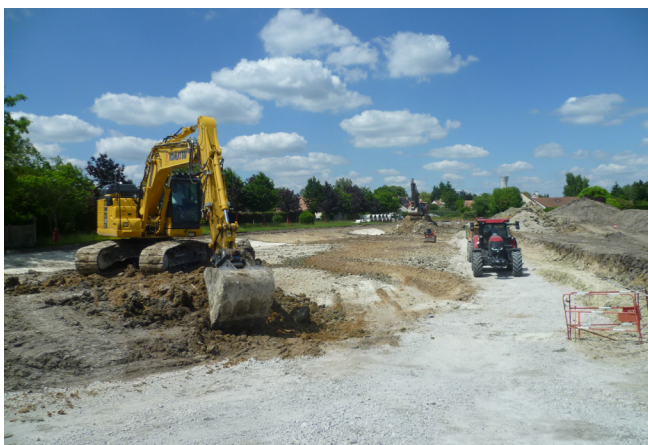
MARIGNY-LES-USAGES – Rue Abbé Lermnier : travaux de création d'un bassin d'orage
