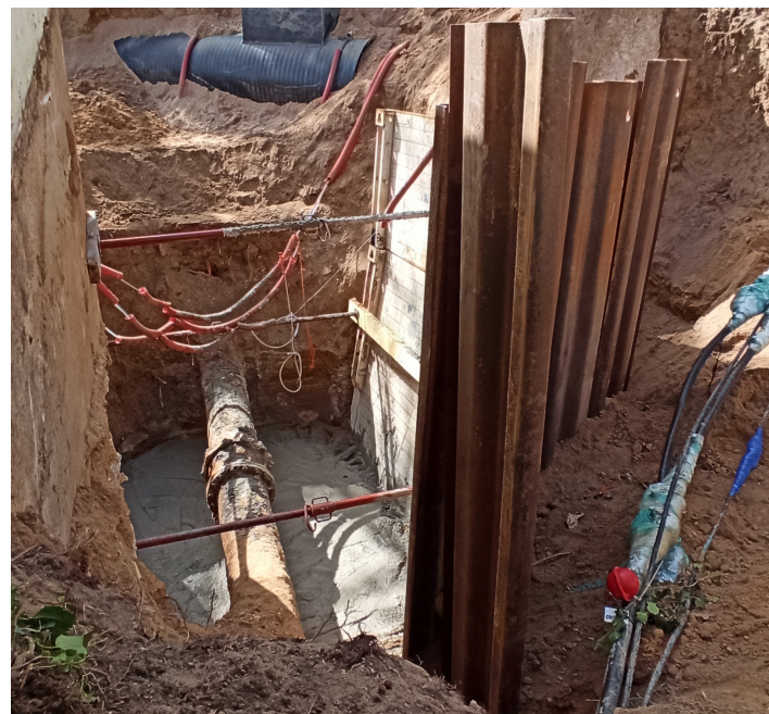
ORLÉANS – Rue Guy de Maupassant : pose d'une vanne d'isolement
