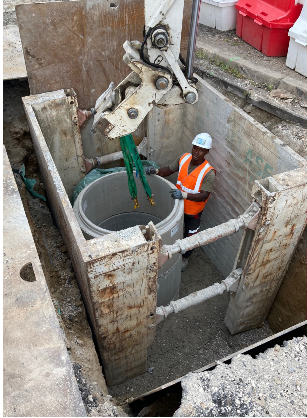
INGRÉ – RD2157 : création de regards de visite
