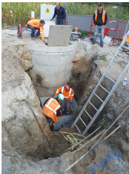
MARIGNY-LES-USAGES – Rue Abbé Lermnier : travaux de création d'un bassin d'orage
