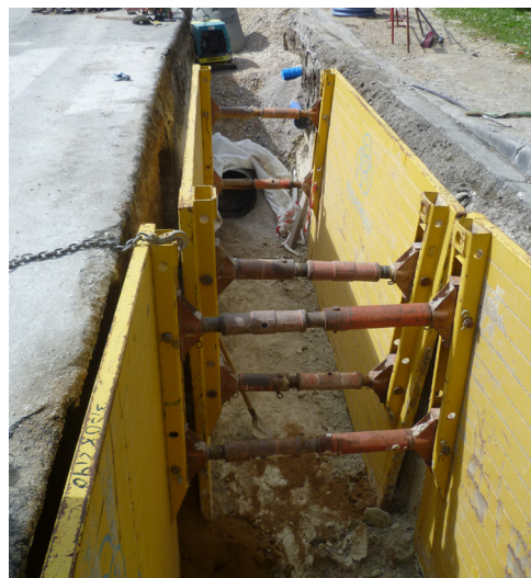
SEMOY – Rue des Barrois : travaux de restructuration du réseau d'eaux pluviales menés conjointement avec le renouvellement de la canalisation d'eau potable
