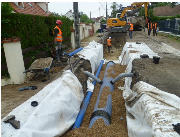
SEMOY – Rue des Barrois : travaux de restructuration du réseau d'eaux pluviales menés conjointement avec le renouvellement de la canalisation d'eau potable
