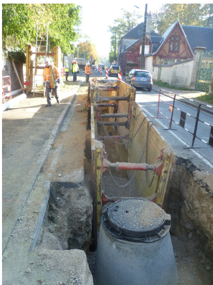
MARIGNY-LES-USAGES – Rue Abbé Lermnier : travaux de création d'un bassin d'orage
