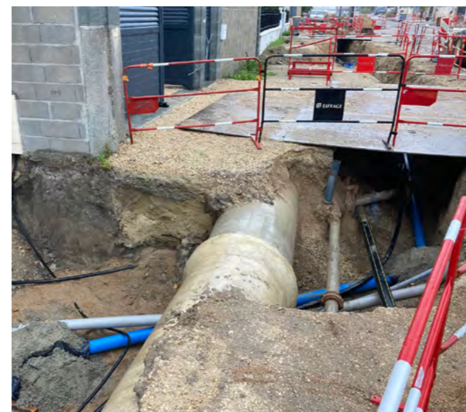
Travaux de renouvellement des réseaux à Ingré
