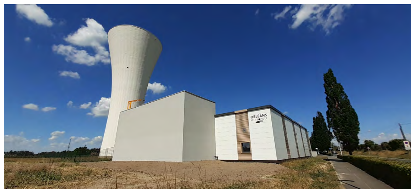
Usine de décarbonation de Saint-Jean-de-Braye
