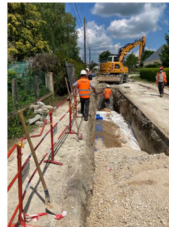
Travaux rue des Barrois à Semoy
