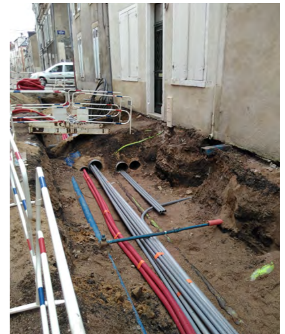
Travaux de remplacement de branchements en plomb à Orléans
