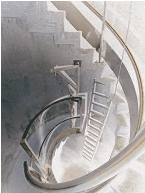
ORLÉANS – Boulevard de Châteaudun : sécurisation des escaliers d'accès au réseau visitable
