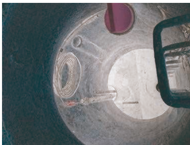
Réparation instrumentation DO2 amont STEP La source
