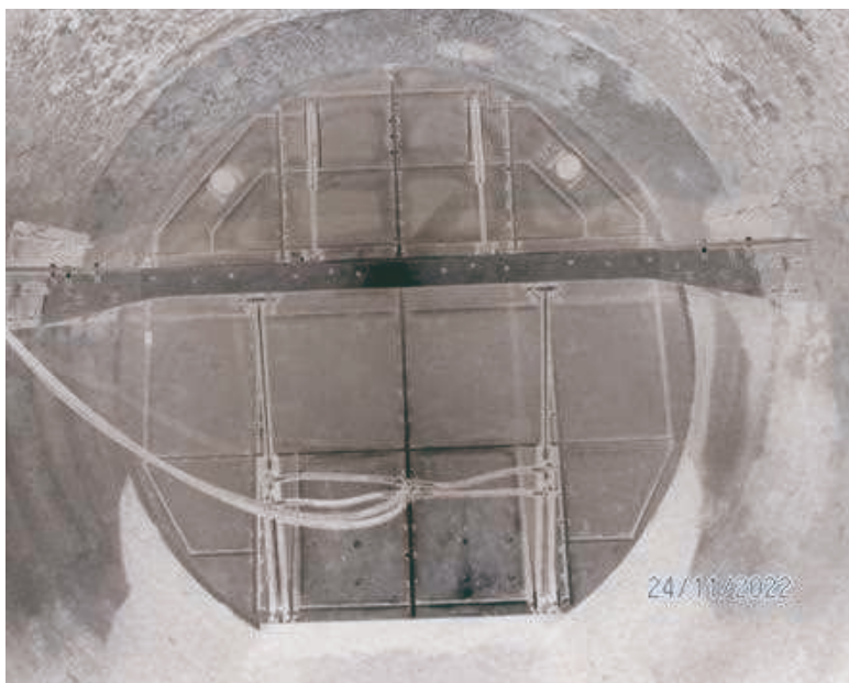
Photo d'une vanne mise en place
