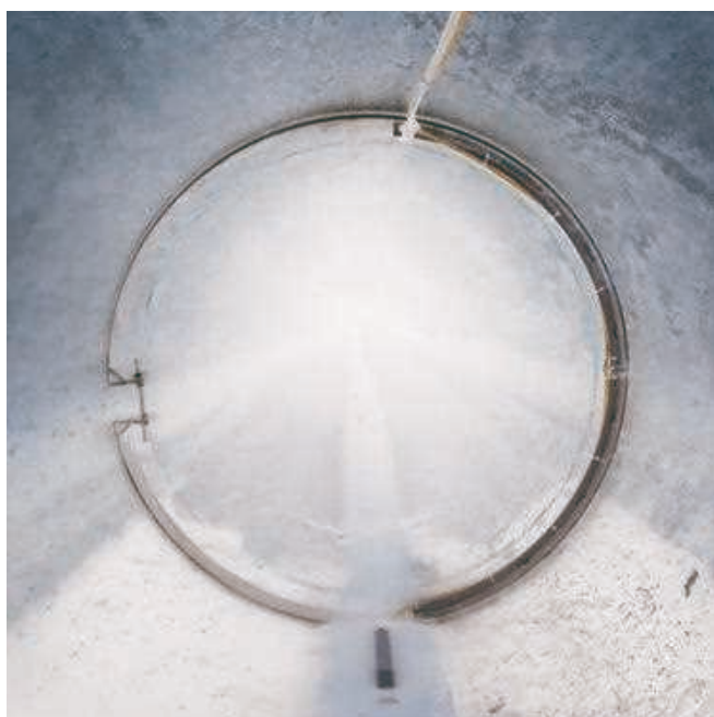
Rééquipement e DN1400mm en sortie du poste Roche
