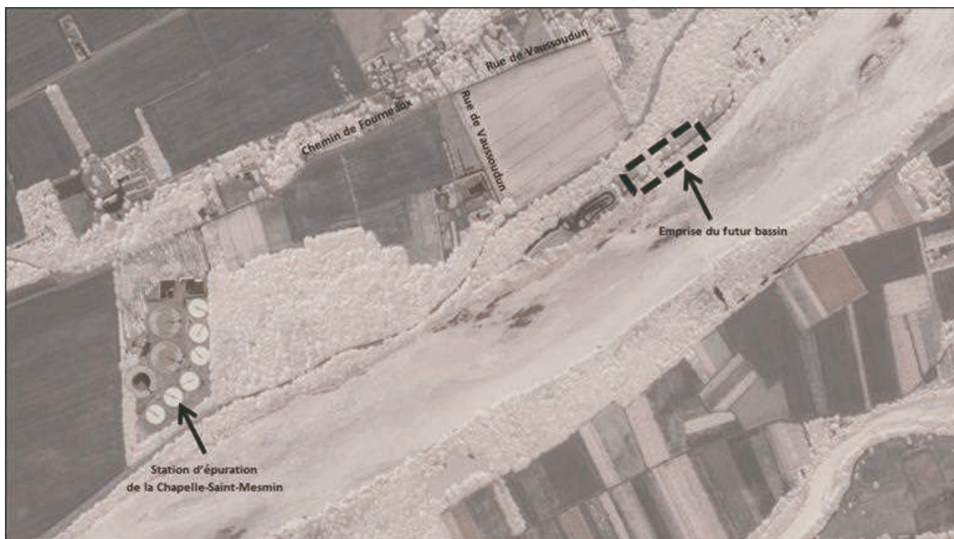
Secteur de Vaussoudun à La Chapelle-Saint-Mesmin
