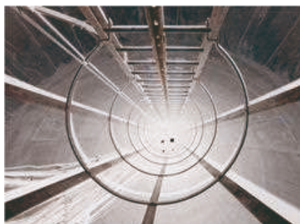
Intérieur du réservoir de Petit Jean (Saint-Jean-de-la-Ruelle)
