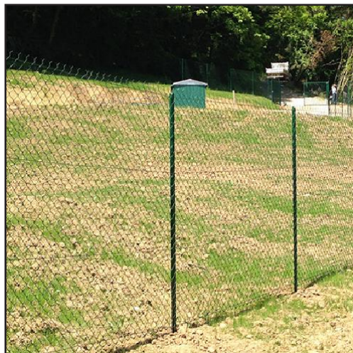
Clôture en grillage
