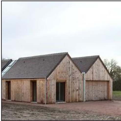
Maison individuelle, Barrault & Pressacco, Gonneville-sur-mer
