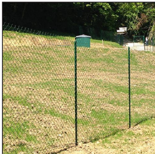
Clôture en grillage
