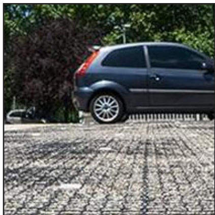
Dalles alvéolées concassé
