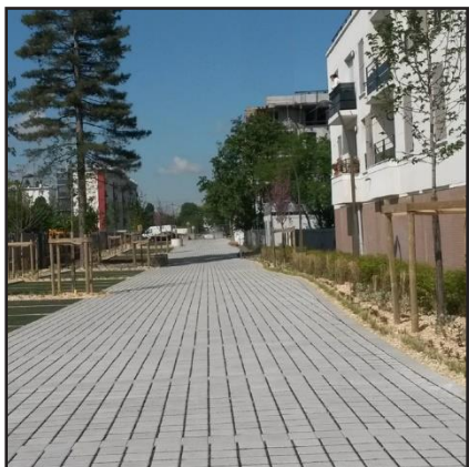
Pavage béton joint concassé (places midi uniquement)
