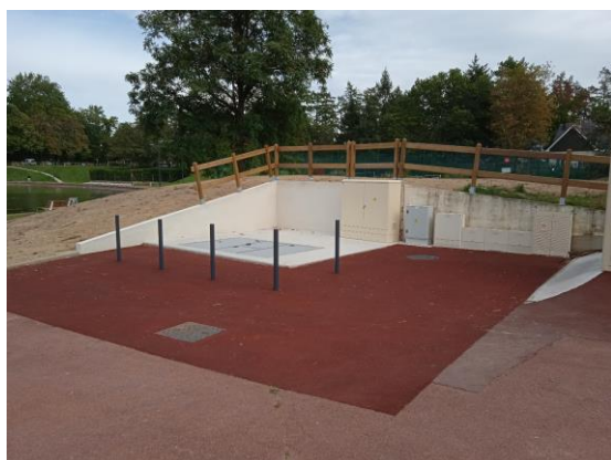
Orléans La Source – Poste Lac Eaux pluviales avant pendant après travaux
