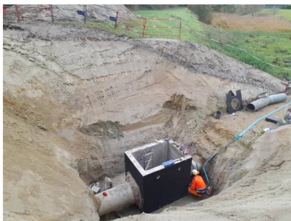
La Chapelle Saint Mesmin - Rue du petit courant - extension de réseau eaux usées avec création de branchements
