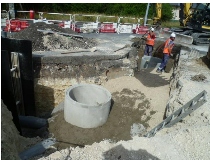
La Chapelle Saint Mesmin - Rue d'Ingré - extension de réseau eaux usées avec création de branchements
