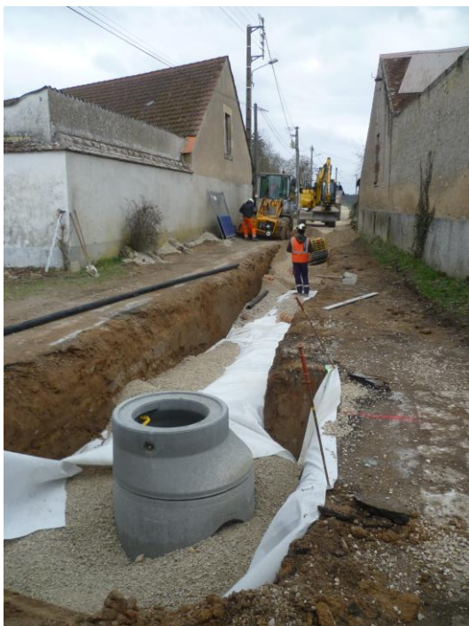
Mardié Rue de Genon - extension de réseau eaux usées avec création de 22 branchements
