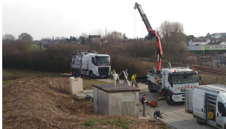
Remplacement des pompes sur le poste eaux usées et eaux pluviales de Pôle 45 à Ormes
