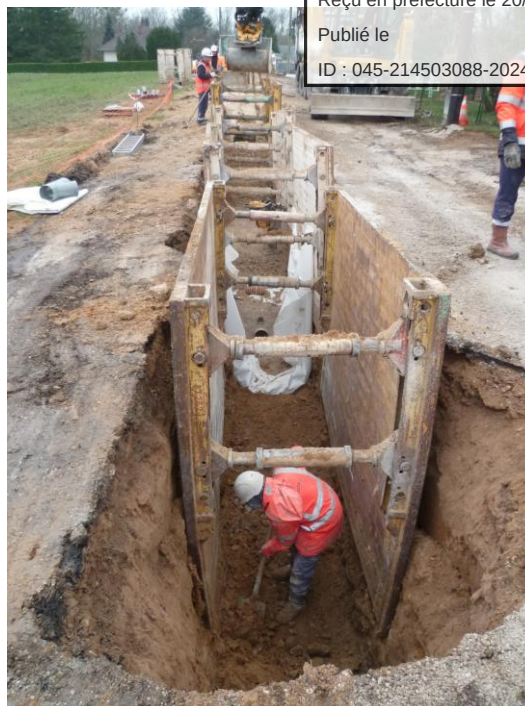
Mardié Rue de Genon - extension de réseau eaux usées avec création de 22 branchements
