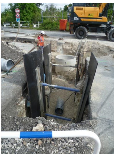
La Chapelle Saint Mesmin - Rue d'Ingré - extension de réseau eaux usées avec création de branchements
