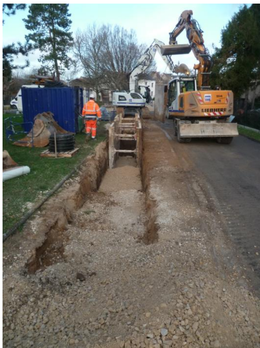
La Chapelle Saint Mesmin - Rue du petit courant - extension de réseau eaux usées avec création de branchements
