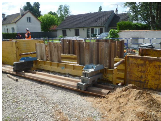
Olivet – Rue du Pressoir Aubry – Extension du réseau eaux usées avec création de branchements
