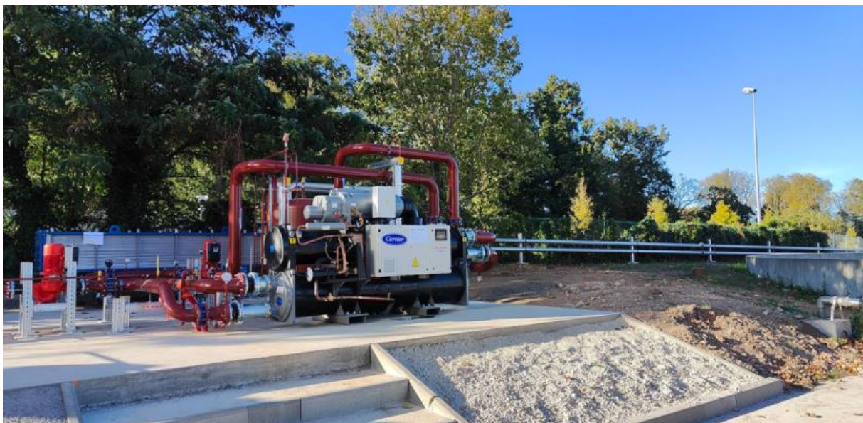
Pompe à chaleur à haute performance (échangeur thermique)
