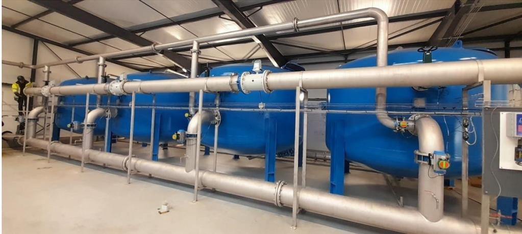
*Usine de déferrisation démantérisation de La Source - 3<sup>ème</sup> file de traitement*
